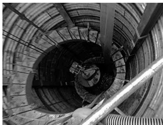
写真-4 発進立坑の構築状況
